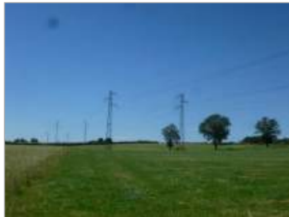
Photographie 29 : Lignes HTB entre la ZIP 3 et la ZIP 3bis (Source : ENCIS Environnement)
